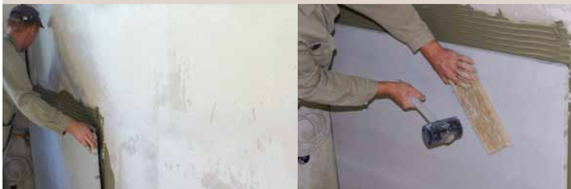
Pose du panneau
