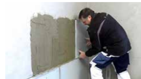
Paroi isolée avec une PLAK SILI-KOAT ® 100mm
